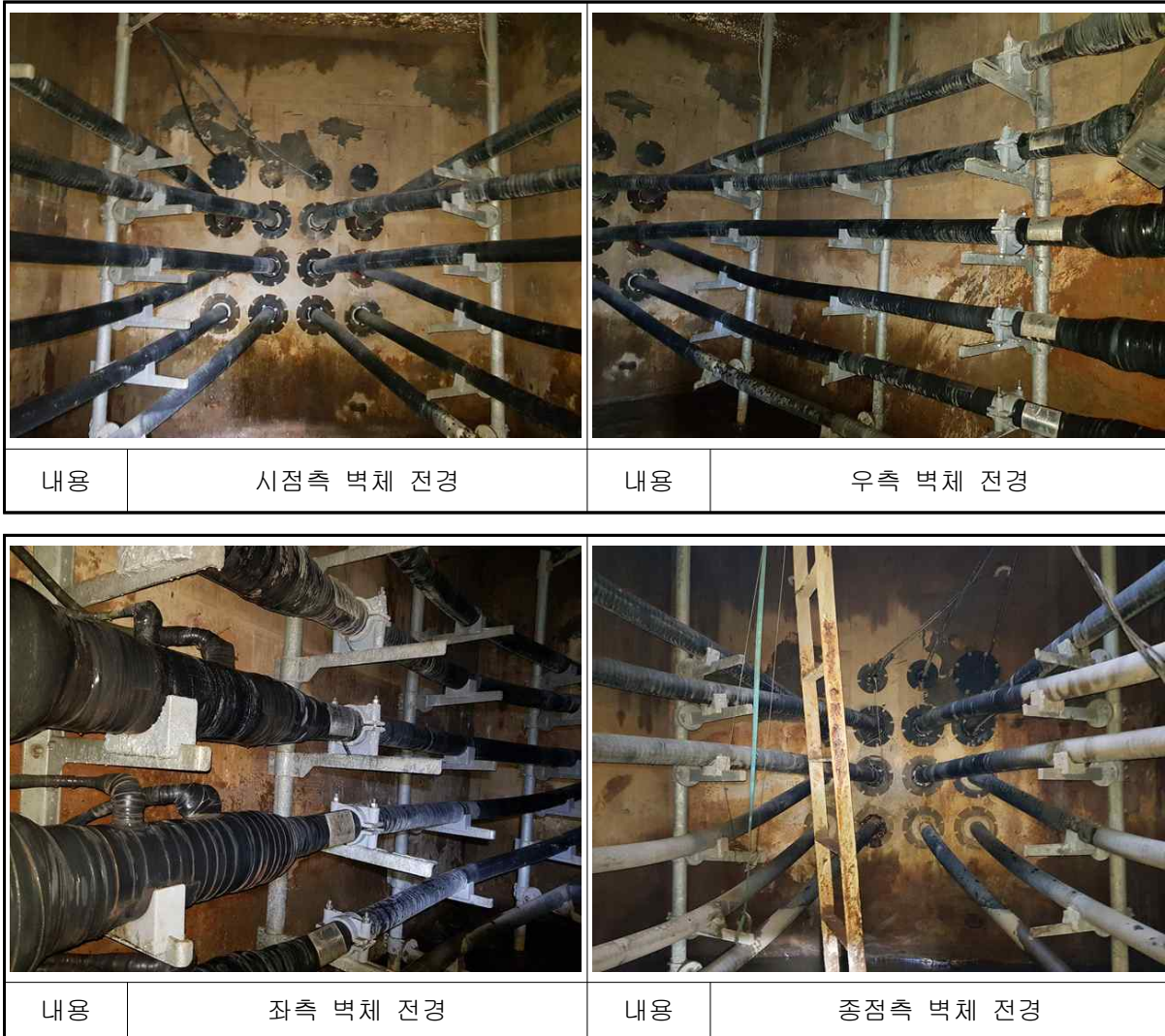
[사진 14.25] 일산~송포#7 전경
