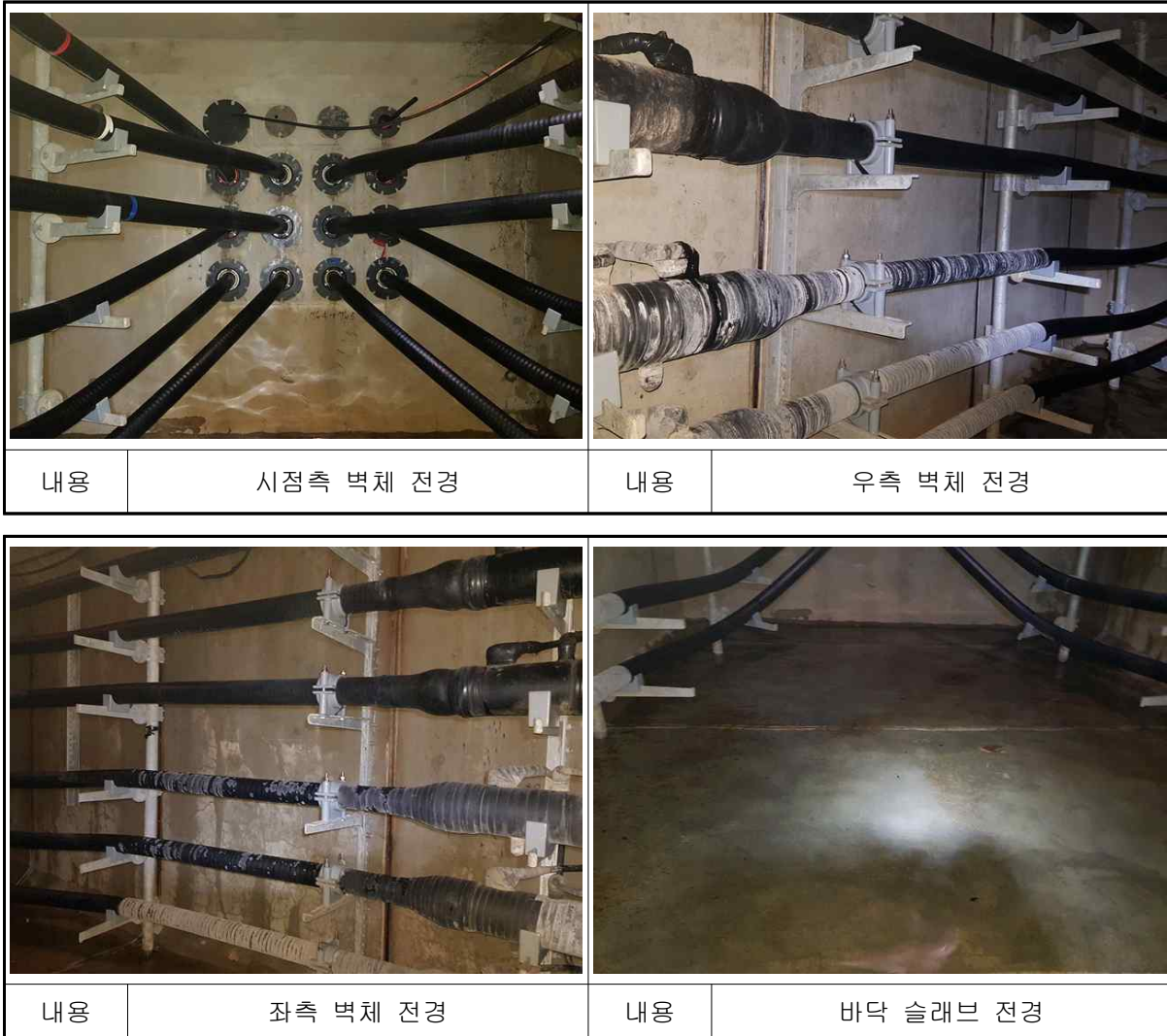
[사진 14.13] 일산~송포#4 전경
