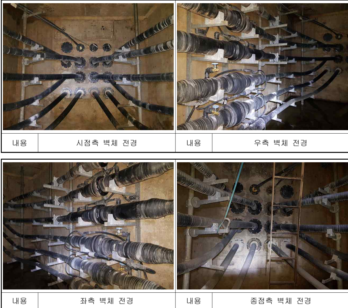
[사진 14.41] 일산~송포#11 전경
